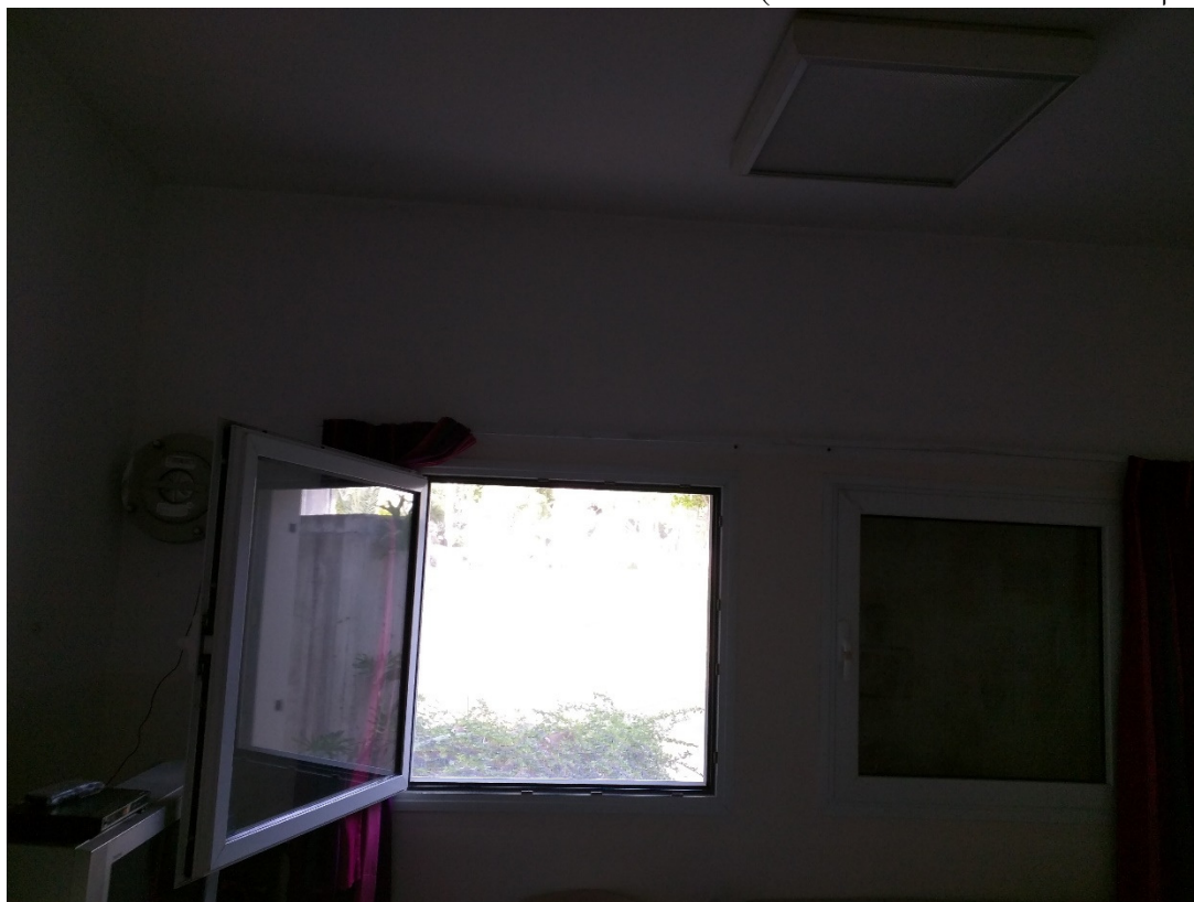
בחדרים הותקנו תקרות תותבות – בחדרי השיירות התקרה הינה תקרה מאריחי פח ובעיקר החדר התקרה הינה תקרת גבס.
